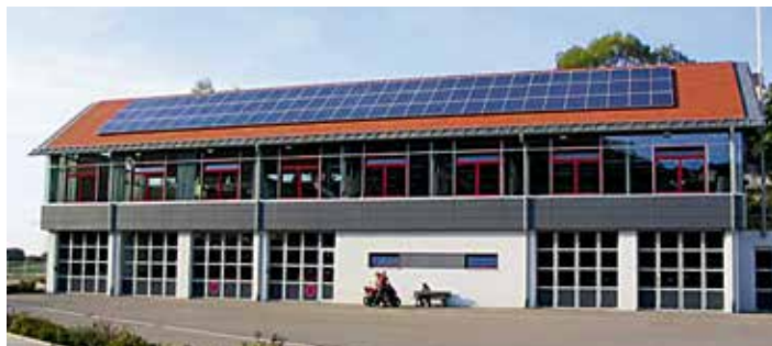
Gemeindezentrum mit Feuerwehr und DRK
