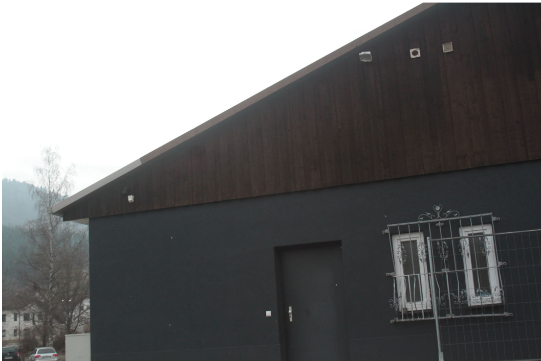
Abb. 4: Blick von Flurstück 179 auf das Dach von Gebäude 4
